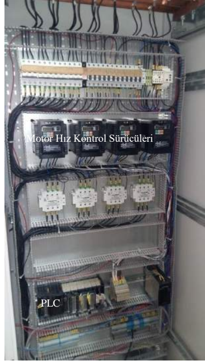
Şekil 2. Kurutma sistemi güç ve kontrol pano fotoğrafı
